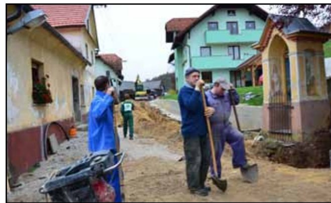
Polaganje optičnega kabla
