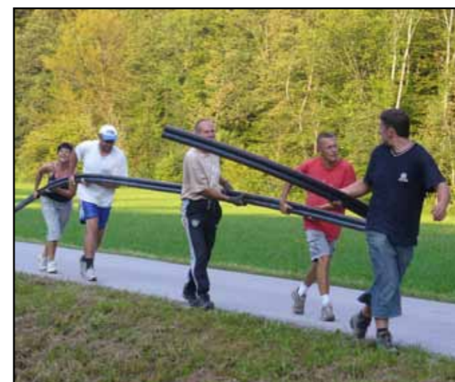
Polaganje optičnega kabla
